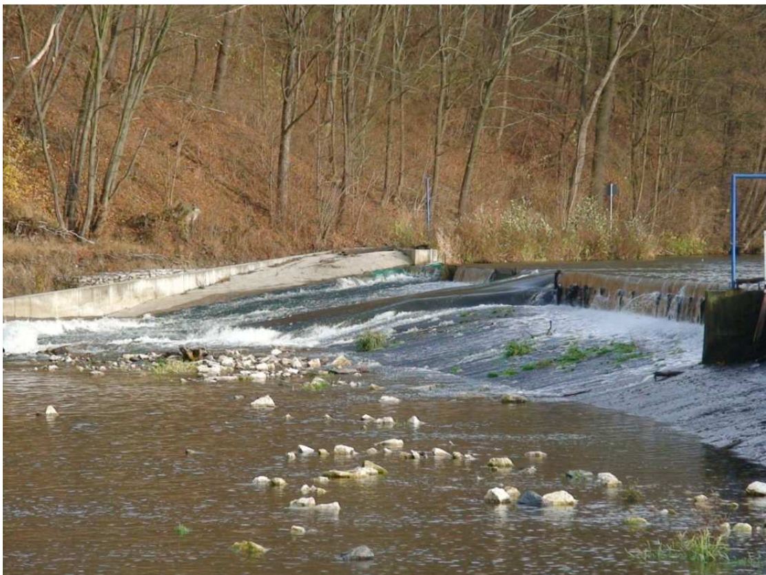
Foto 51: Wasserabgabe über das Wehr bei Durchflüssen, die über das Schluckvermögen der Turbine hinausgehen
