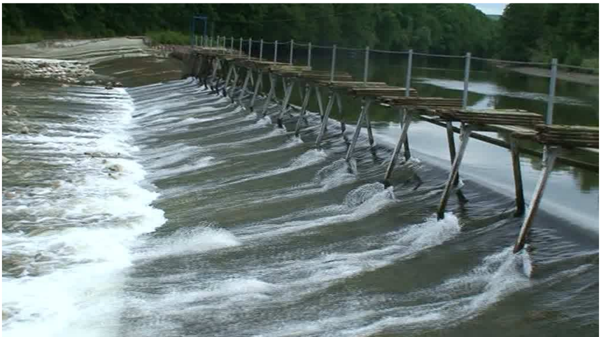
Foto 6: geöffnetes Nadelwehr
