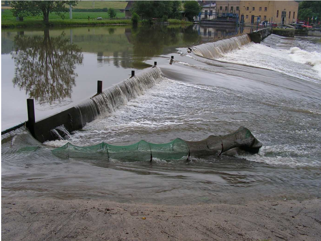
Foto 52: Wasserabgabe über die mittleren Wehrfelder
