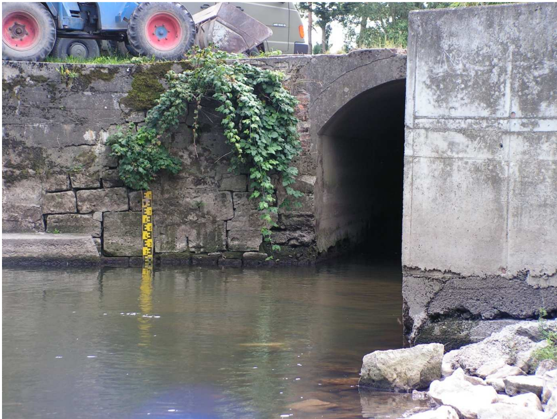
Foto 24: Auslaufbereich des Freischusskanals
