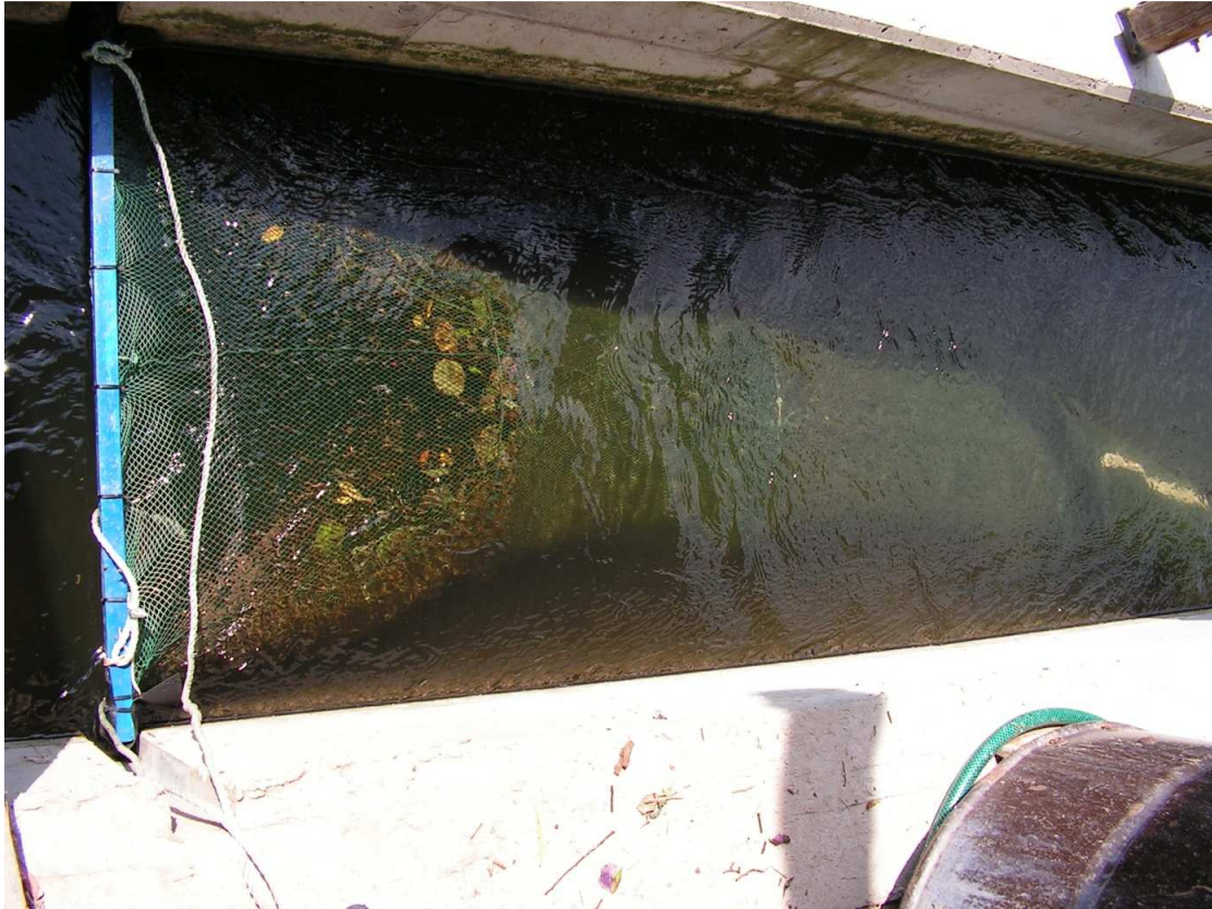
Foto 38: Reuse im Schlitzpass
