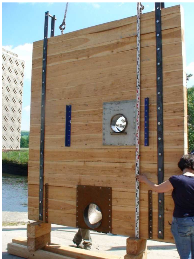
Foto 21: Einbau des mittleren Bypassrohres und Erneuerung des Schützes
