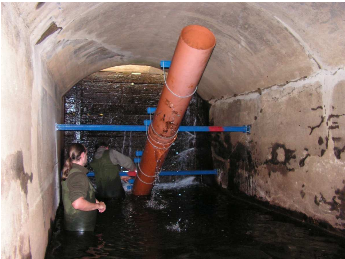
Foto 19: Bypassrohr im Leerschusskanal
