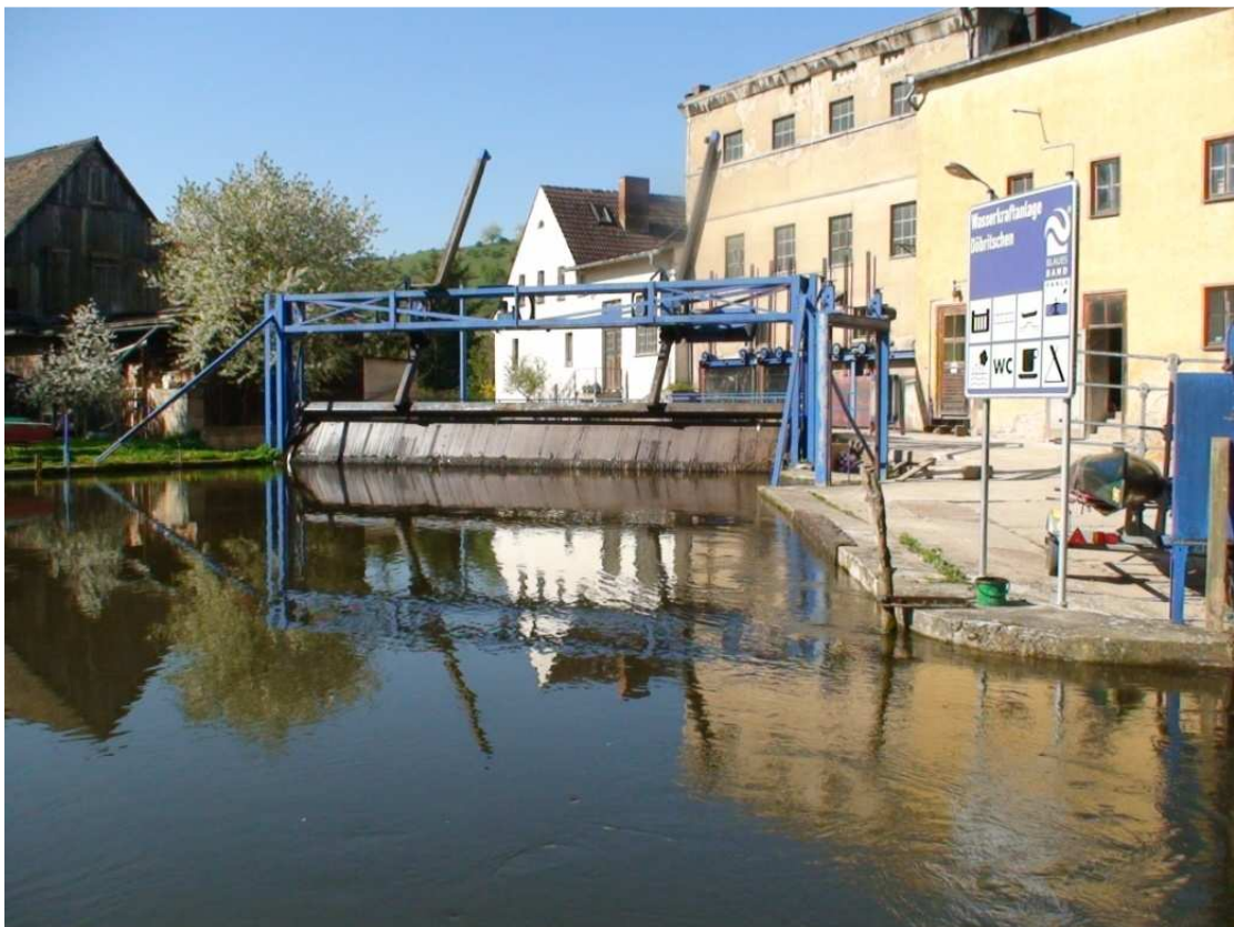
Foto 2: Rechenanlage der WKA Döbritschen
