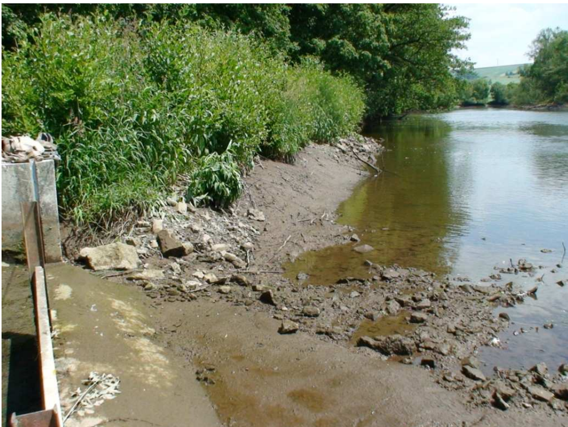
Foto 53: Sohlverhältnisse am Wehr bei abgelassenem Stauraum
