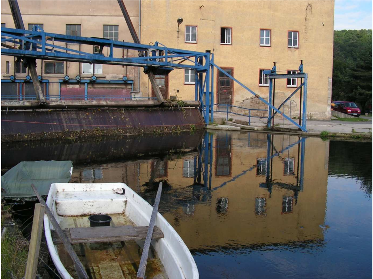
Foto 3: Rechen mit Rechenreiniger
