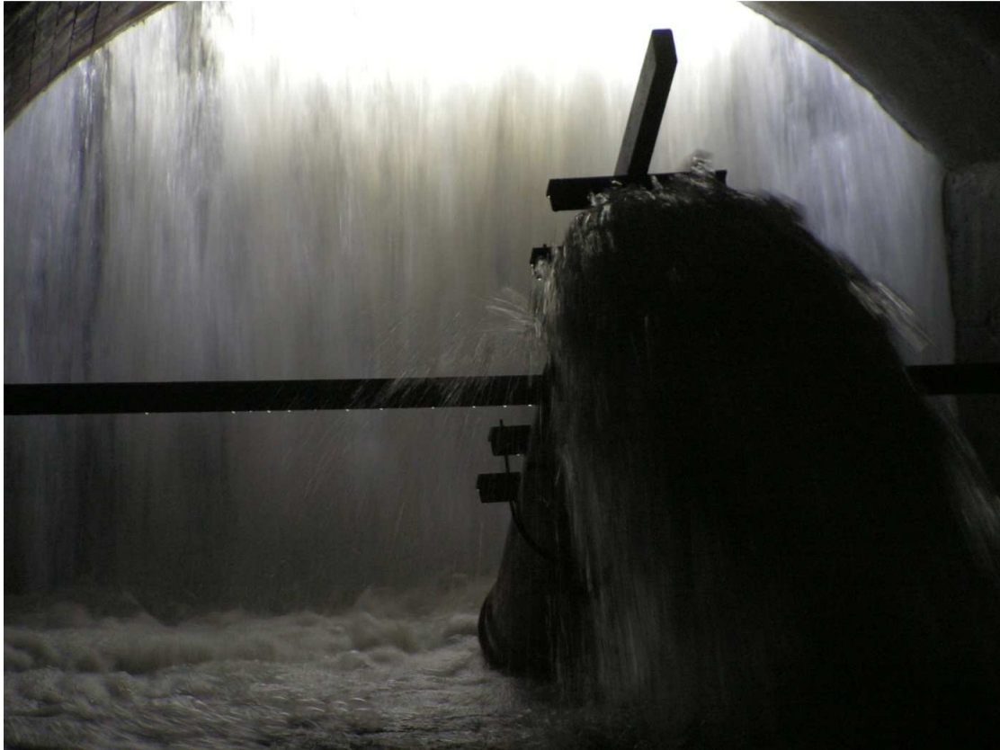
Foto 28: Betrieb des mittleren Rohres des bodennahen Bypasssystems
