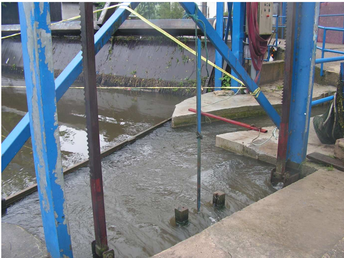
Foto 29: Überströmung des Freischussschützes
