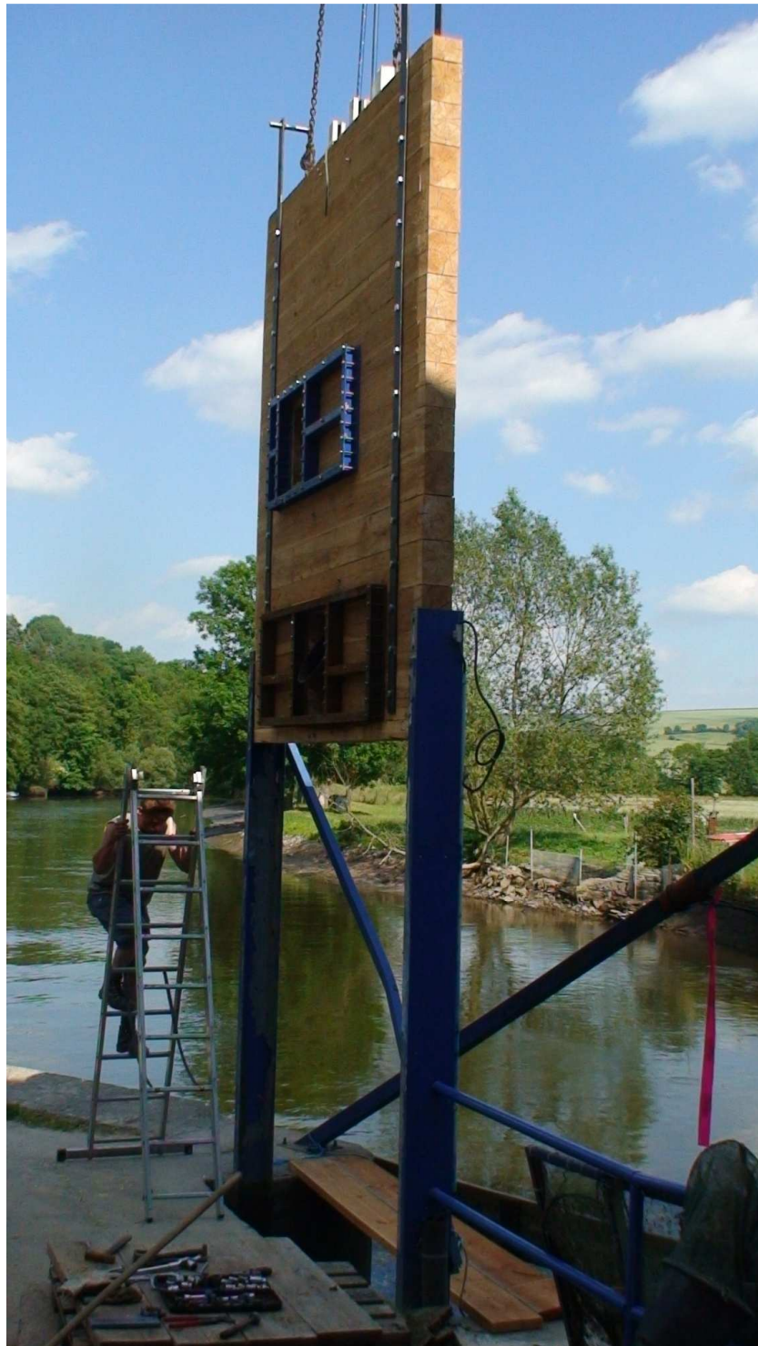
Foto 23: Einsetzen des Schützes
